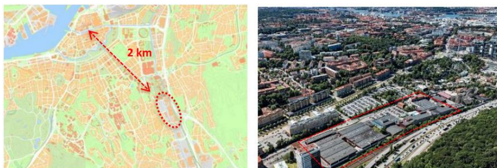
Figur 3. Planområdet ligger mellan Mölndalsån och E6 direkt söder om nuvarande Lisebergsområde, cirka 2 km söder om Göteborgs centrum. Flera av byggnaderna inom planområdet på bilden har rivits (Bildkälla: Stadsbyggnadskontoret, Göteborgs stad).
