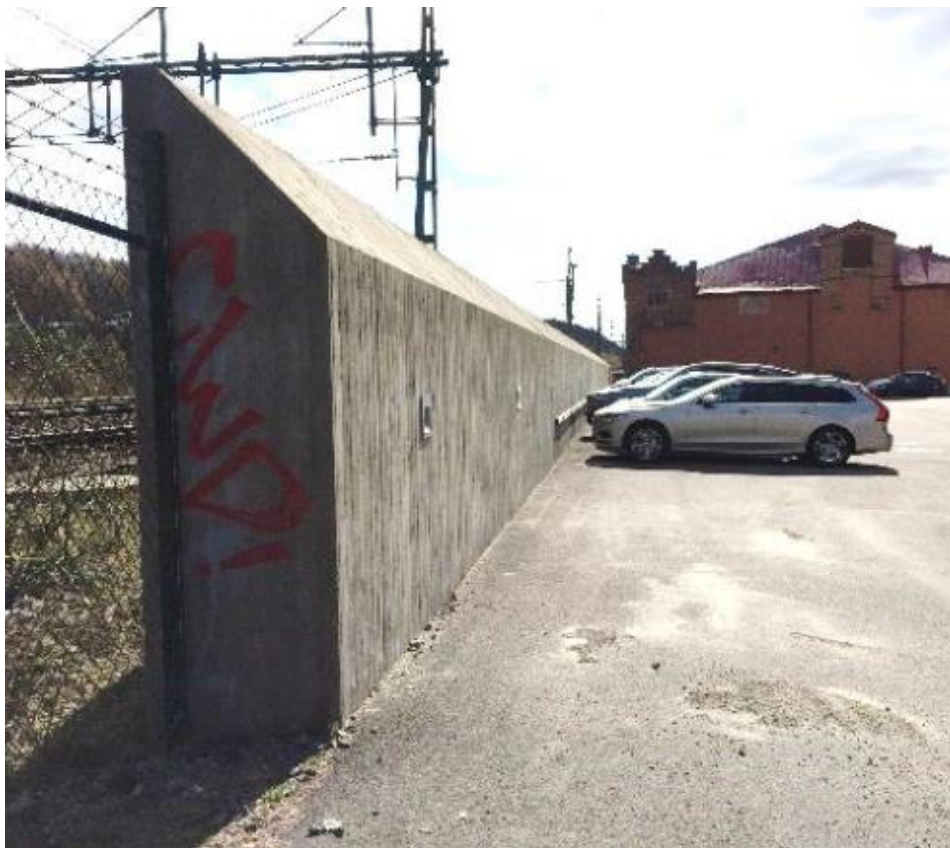
Figur 17. Befintlig skyddsmur på PEAB:s fastighet söder om planområdet (Bildkälla: Stadsbyggnadskontoret, Göteborgs stad).
